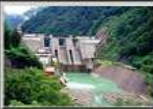
上・中流部ダム
